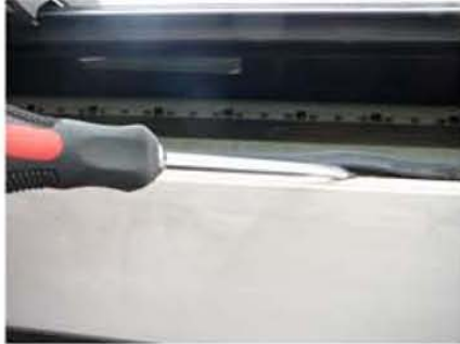
alte Dichtg. entfernen
