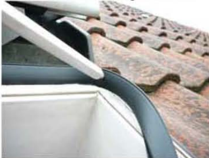
bis zur Gehrung einziehen und die Mitte der Gehrung Makieren
