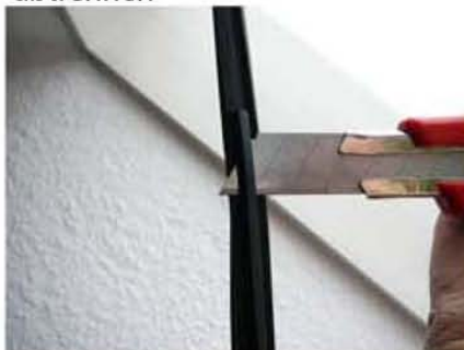
mit Cuttermesser den unteren Steg abtrennen
