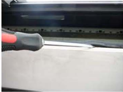
alte Dichtg. entfernen
