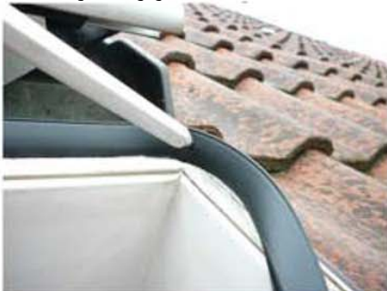
Die kleineren Ausstanzungen im Dichtungs-Ring gehören nach oben
