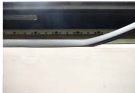
Mit der Neuen Dichtung oben an den Ecken rechts und Links beginnen!
