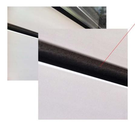
je nach Temparatur kann es bis zu einem Tag dauern, bis das Kompriband richtig aufgeqollen ist
