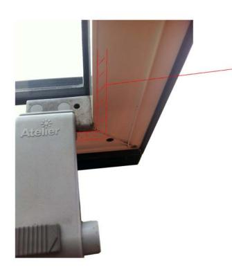
Flügelrahmen im Bereich wo das Kompriband aufgebracht wird mit Essig- oder Glasreiniger säubern
