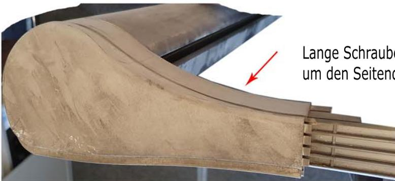
Lange Schraube auf der Innenseite entfernen,
