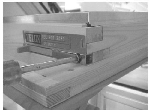
3. Anschließend den Putzriegel hinausschieben und die zweite Schraube herausschrauben.
