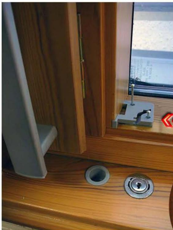
Neuer Velux Ersatz Zubehörträger Art-Nr 8666\_843621 wird mit 2 Nägel befestigt ein Nagel rutscht bis zu 2/3 ins vorhandene Loch. Halt bekommt man aber trotzdem durch den zweiten Nagel..
