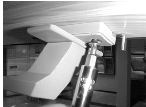
5. Den neuen Handgriff montieren. Die Handgriffbuchsen sind in die Vorbohrungen des Flügelunterteils einzuführen. Wenn der Handgriff einen Verschluss hat, ist die korrekte Anordnung des Riegels bei der Montage zu beachten.
