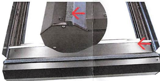
Abb. C Kompriband wie im Bild an der Kante des Rollladenkastens aufkleben!
